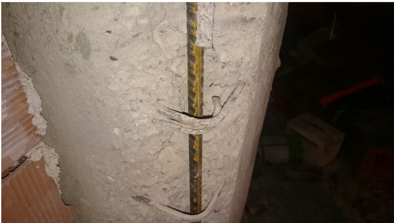
Particolare prelievo ferri di armatura
