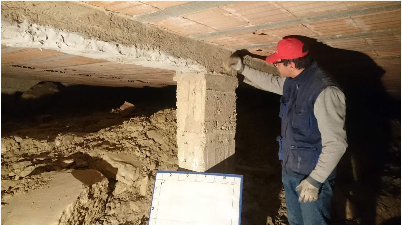
Particolare interno locale fondazioni
