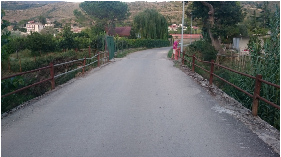
Attraversamento su torrente "Arena"
